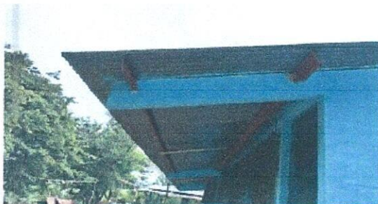
Foto 5: MANTENIMIENTO Y PINTURA ESTRUCTURA DE TECHO EN MODULOS
