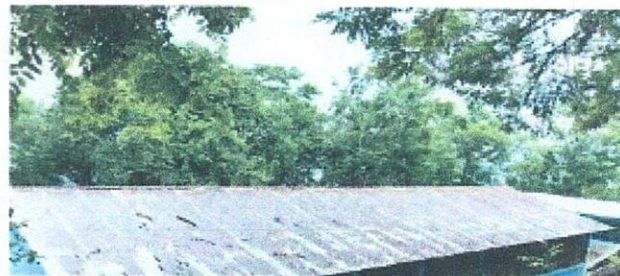
Foto 2: SUSTITUCIÓN CUBIERTA DE LAMINA TROQUELADA CALIBRE 26 EN MODULOS
