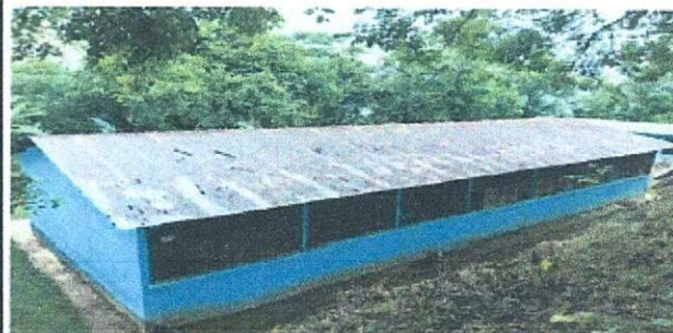
Foto 4: INSTALACIÓN DE BAJADAS PLUVIALES CON CANAL GALVANIZADO
